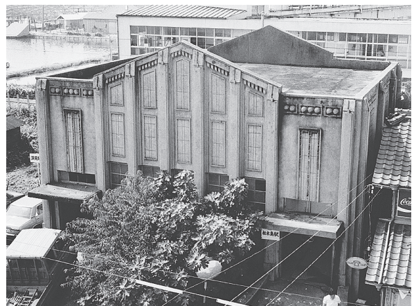
かつて「神谷」の名称が付けられた松木島の駅舎
