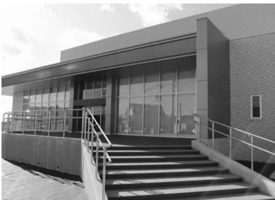
引き渡しを受けた、きら市民交流センター（仮称）支所棟の現在の様子
