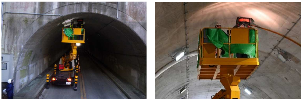
写真-3.1 専門業者による非破壊検査の状況
