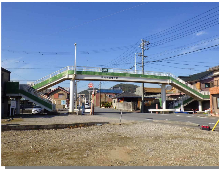
西幡豆駅前歩道橋(昭和 44 年完成)
