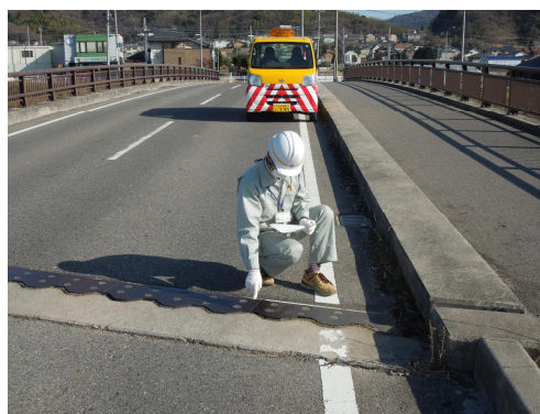
写真-3.4 道路パトロール状況②
