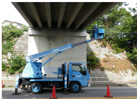
写真-3.1 専門業者による点検状況①
