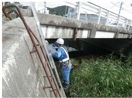
写真-3.2 専門業者による点検状況②
