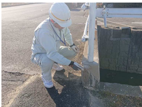
写真-3.5 コンクリートの修繕
