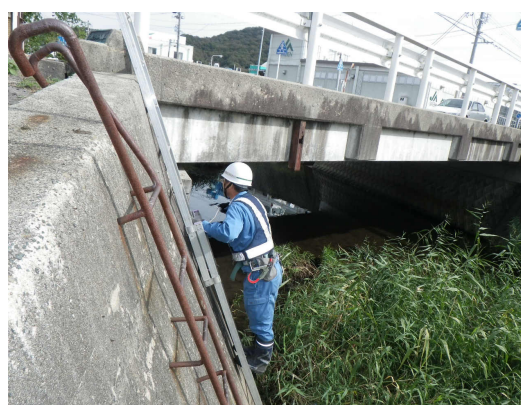
写真-3.2 専門業者による点検状況②
