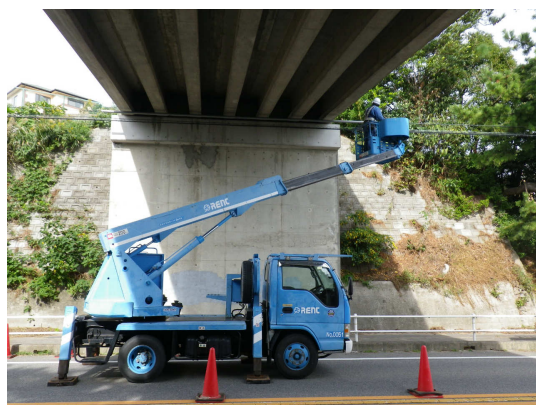
写真-3.1 専門業者による点検状況①
