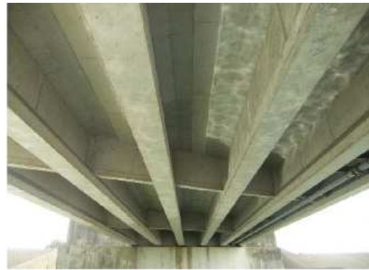
写-2.2 P C橋
