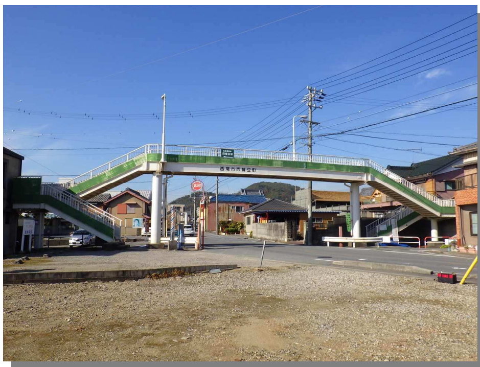
西幡豆駅前歩道橋(昭和 44 年完成)
