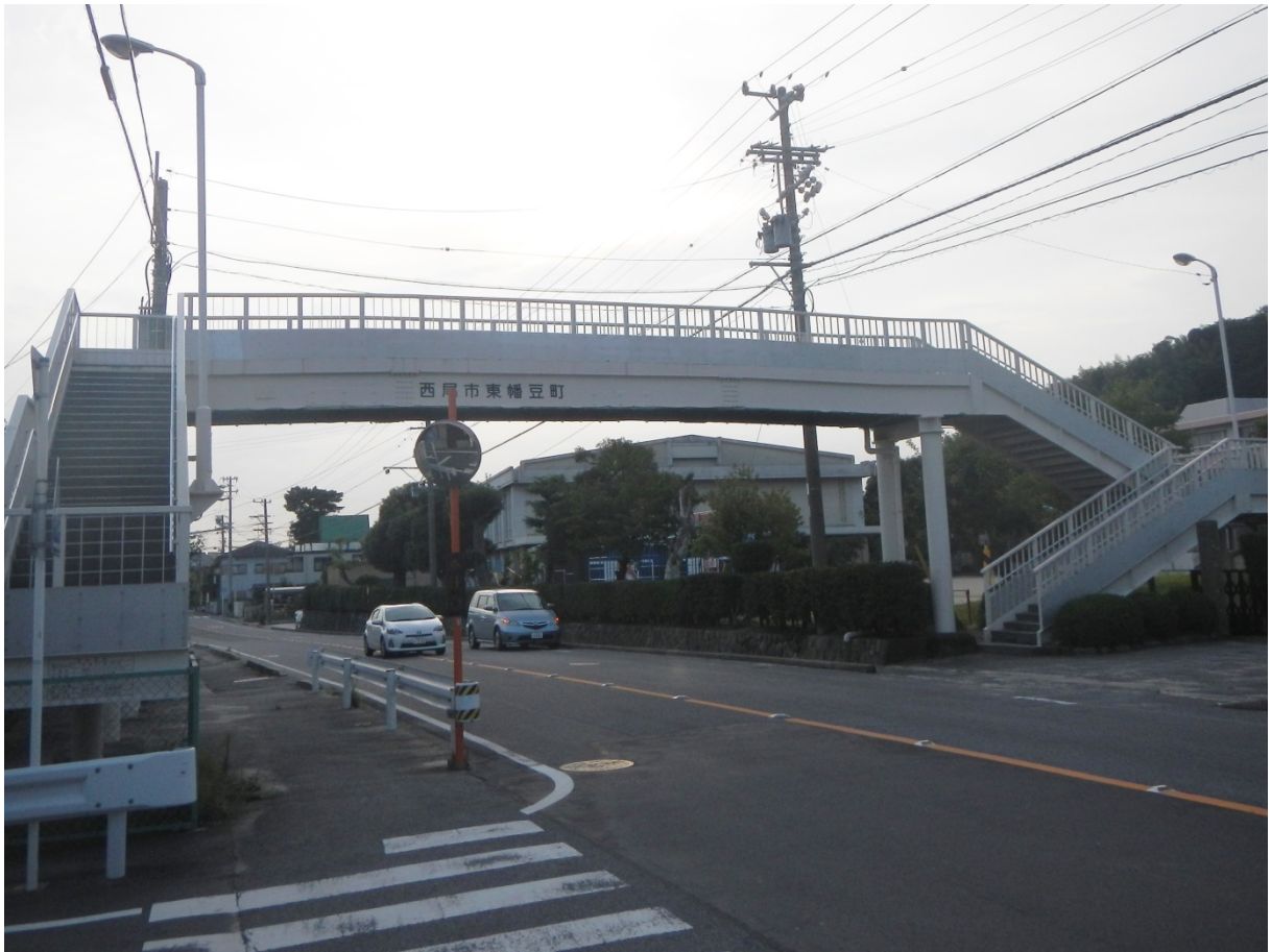
市道幡豆 652 号線と東幡豆歩道橋
