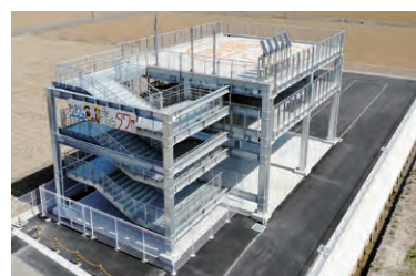
津波避難タワー建設事業 (3億5,069万円)
