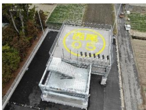
奥田地区津波避難タワー (令和6年度整備)
