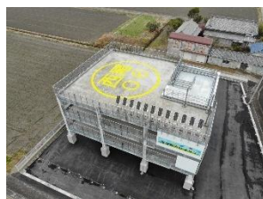
治明地区津波避難タワー (令和6年度整備)
