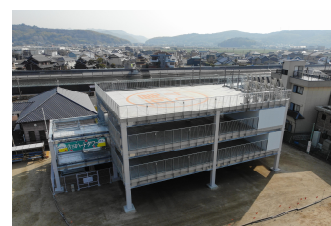
吉田地区 津波避難タワー (令和4年度整備)
