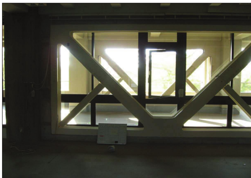
ブレース（筋交い）の設置状況
