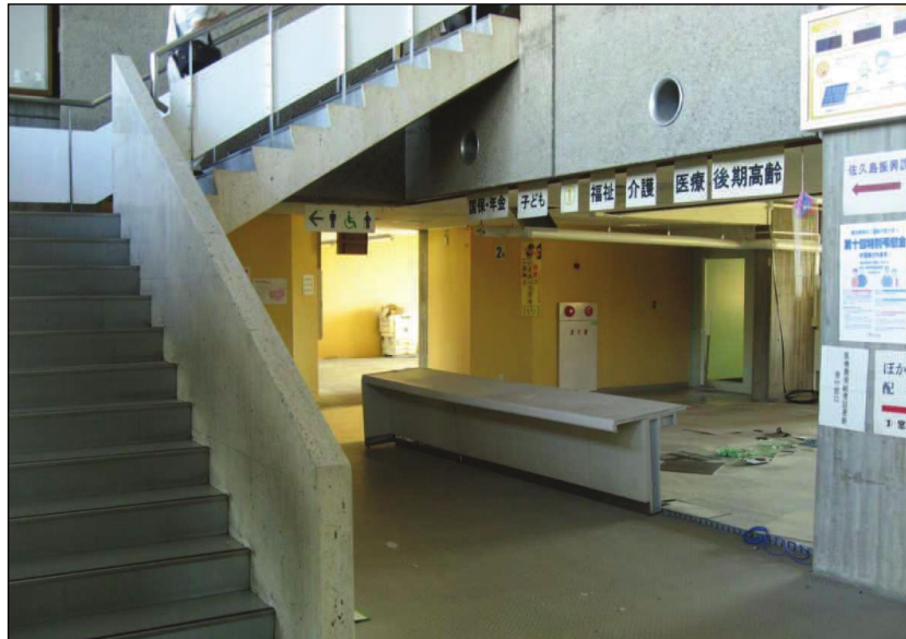
2～5階の天井の一部にアスベストを含む塗装
