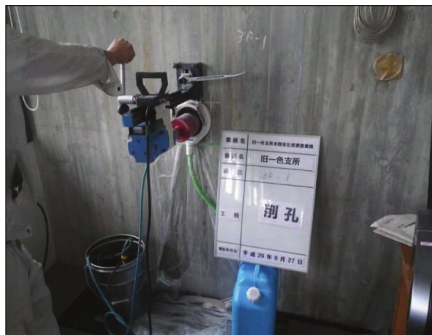
コンクリートの抜き取り
