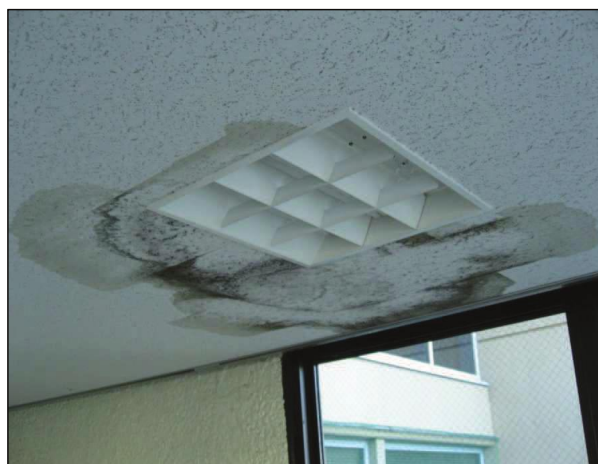
1階天井に雨漏りの疑い
