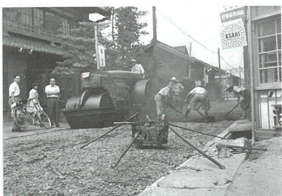
写真③ 三間通りの道路タール舗装工事 吾妻町(昭和20年代頃か)
