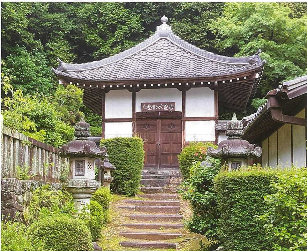
華蔵寺御影堂 (吉良町 吉良上野介義央公の座像安置)
