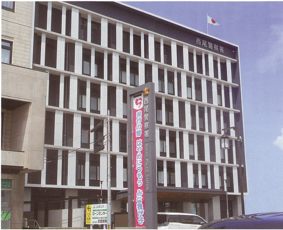
「2020年8月31日、西尾市寄住町に西尾警察署の新庁舎が完成しました。」
