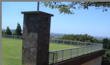
八ツ面第3配水池（10,000m 3 ）
