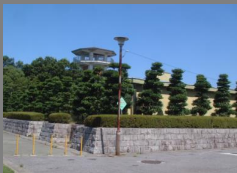
八ツ面第1配水池（4,000m 3 ）
