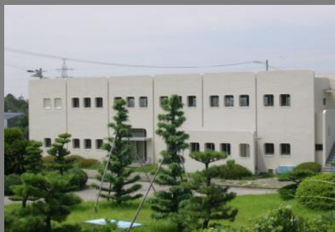
志貴野水源送水場
